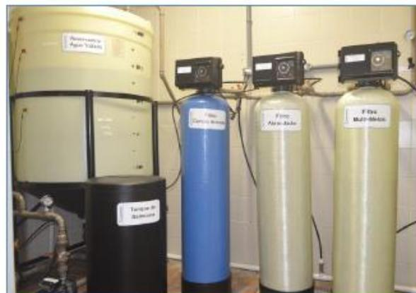
Figura 10 – Imagem do equipamento utilizado para o tratamento da água de osmose da CME do HSP.
