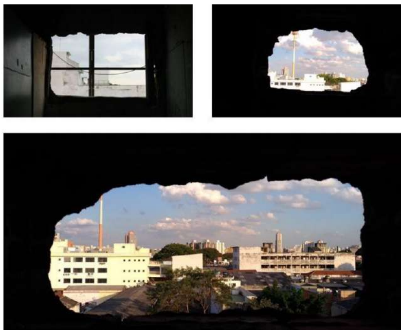
Figura 4. Janelas improvisadas na Ocupação Armênia. Tamiris de Souza Gonçalves, 2016, São Paulo.
